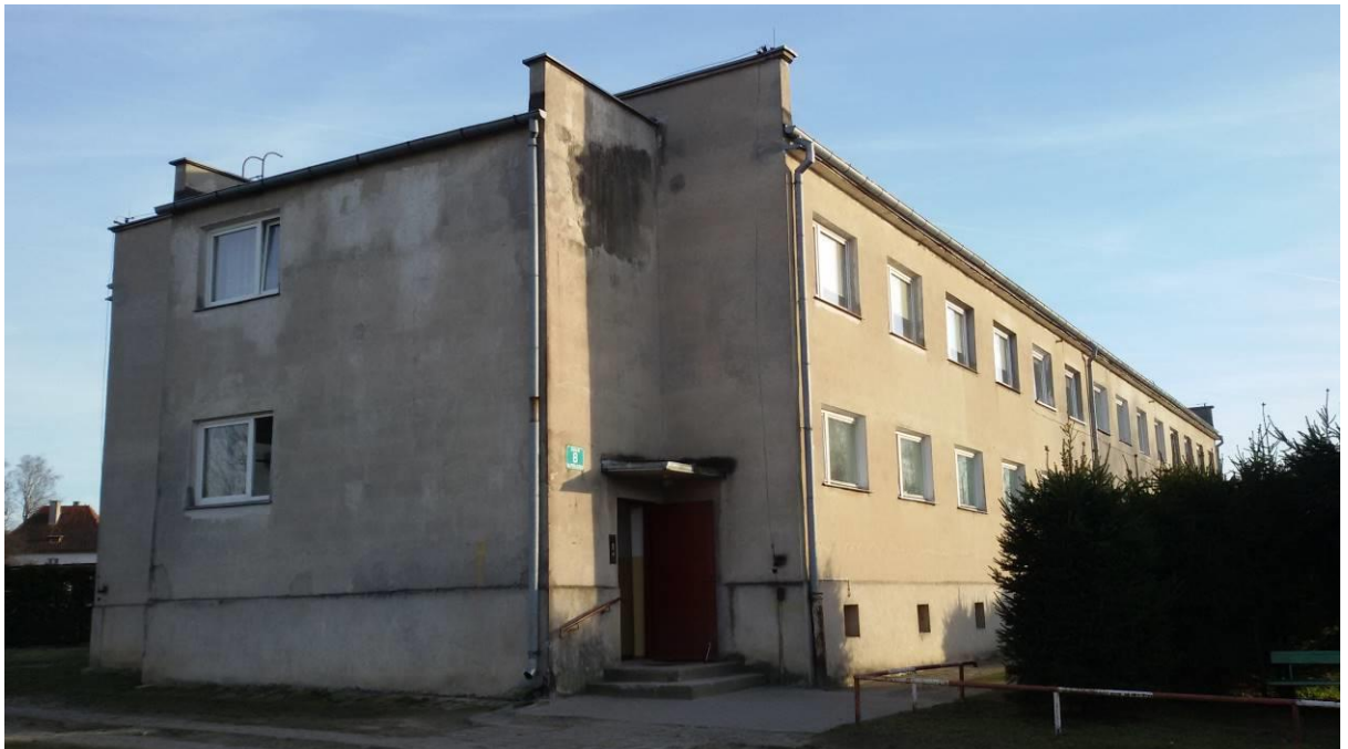
Fot. 2 – Elewacja północno - wschodnia i zachodnio – północna. Na klatce schodowej widoczne wyraźne przebarwienie tynku, najprawdopodobniej spowodowane zaciekanie wód opadowych ze stropodachu
