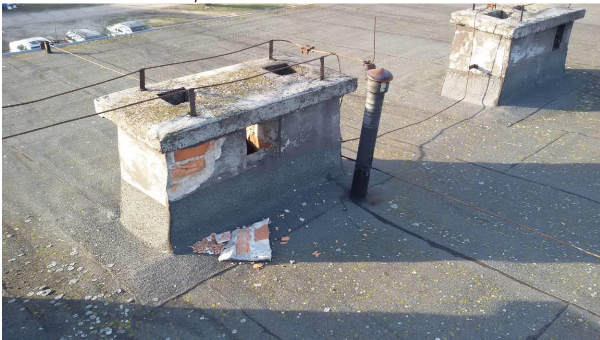
Fot. 3 – Widoczne uszkodzenia tynków na kominach
