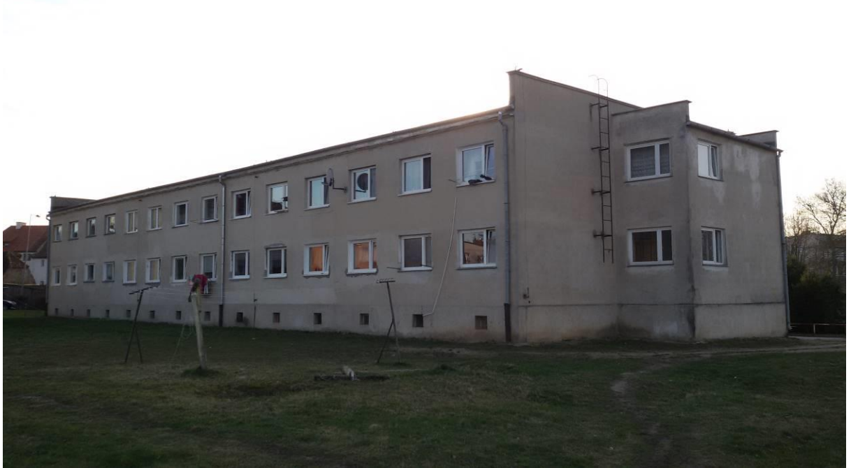
Fot. 2 – Elewacja północno - wschodnia i zachodnio – północna. Na klatce schodowej widoczne wyraźne przebarwienie tynku, najprawdopodobniej spowodowane zaciekanie wód opadowych ze stropodachu
