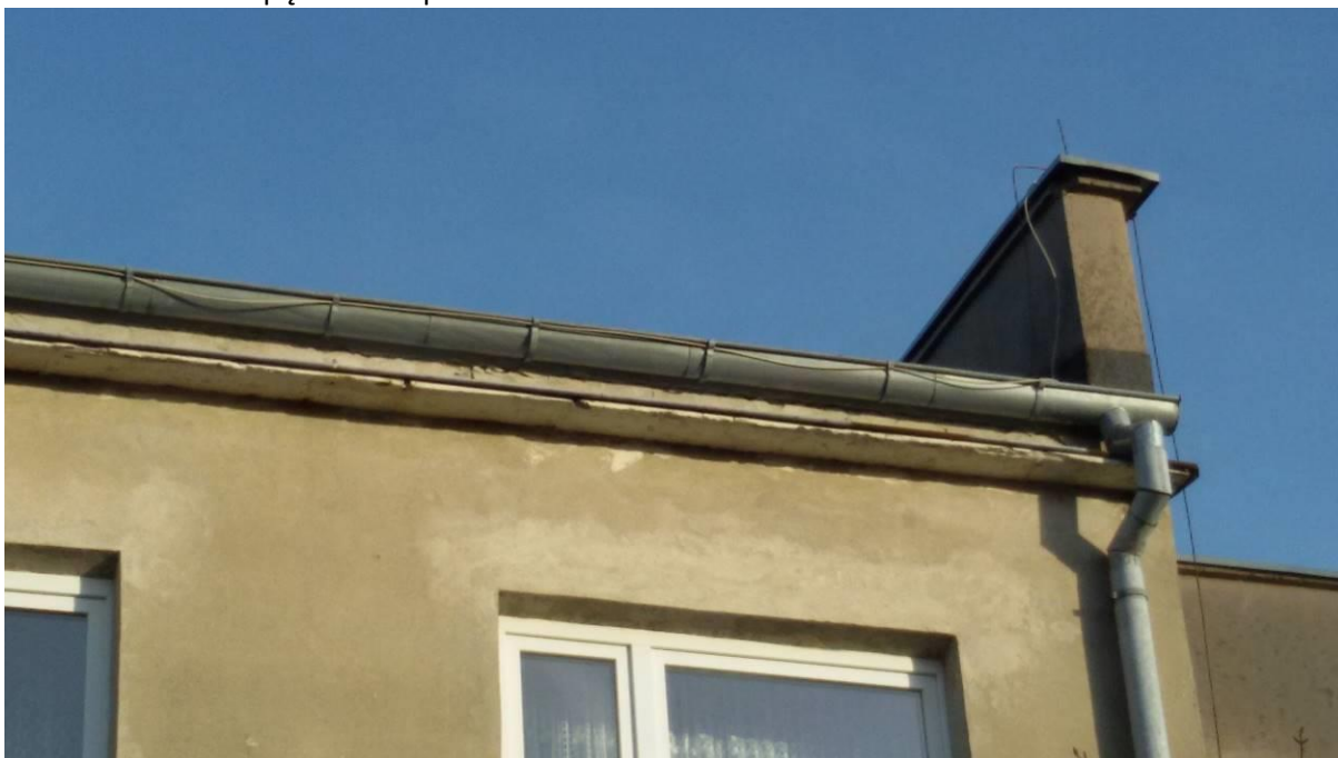
Fot. 4 – Widoczne spękania okapów
